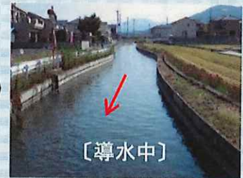
導水の状況(小倉地区)
