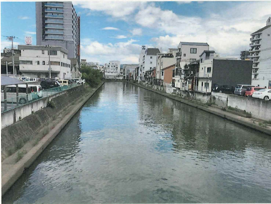
現況（寄合橋下流側）
